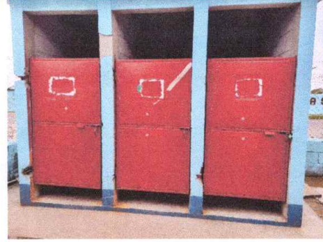
Foto 2: Sustitución de puertas de metal de los baños.
