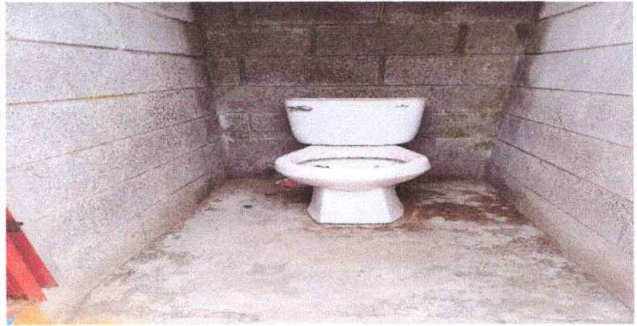
Foto 6: Sustitución de tazas de inodoro
