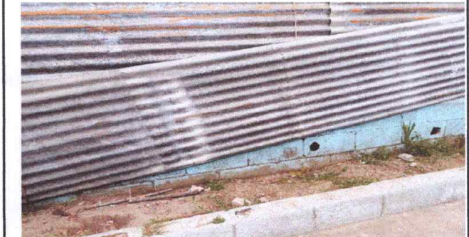
Foto 8: Reparación de muro perimetral de tubo hg y malla galvanizada.
