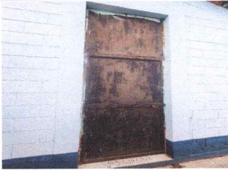
Foto 1: Mantenimiento de las puertas de metal de las aulas.
