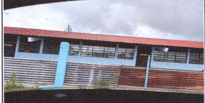
Foto 10: Mantenimiento y pintura de techo.
