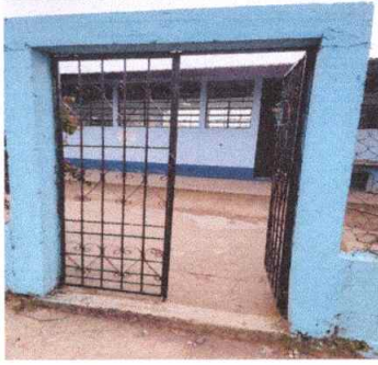
Foto 7: Mantenimiento a portones de metal.
