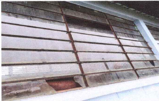
Foto 3: Sustitución de vidrios.
