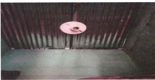
Foto 9: Sustitución de plafoneras y lámparas tipo LED.
