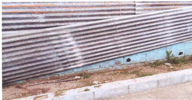
Foto 5: Pintura en muros exteriores e interiores.
